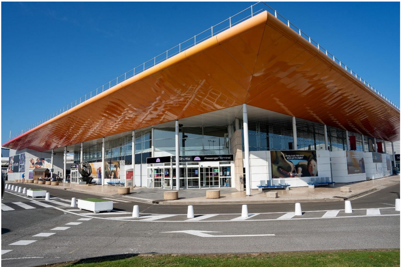
Terminal Passagers de Coquelles
